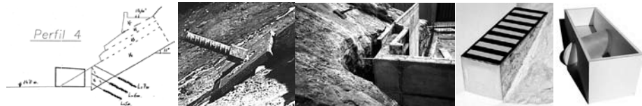
Juan Ignacio RODRIGUEZ AVIAL, ingénieur géotechnicien, «Ispilu Ainguratua» («Miroir Ancré», «Espejo Anclado»), Paseo Nuevo, Saint-Sébastien, 2002. Vingt cinq tirants disposés autour de l'excavation pénètrent dans la pierre à une profondeur moyenne de sept mètres. Ils renvoient les forces de gravité au cœur de la montagne. dessin: Juan Ignacio Rodriguez Avial.
